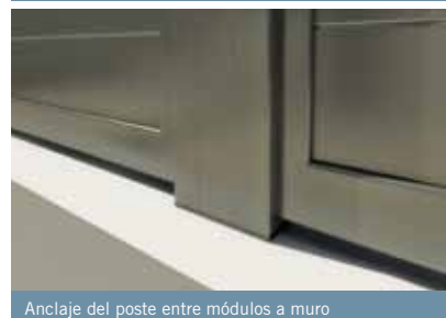
Anclaje del poste entre módulos a muro
